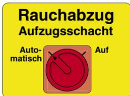
Abbildung 2: Der Schalter zur Bedienung der Lüftungsklappen im Aufzugsschacht respektive im Maschinenraum. Wichtig ist eine sehr gut sichtbare Beschriftung. Anstelle eines Drehschalters lässt sich auch ein Feuerweh-Schlüsselschalter installieren.
